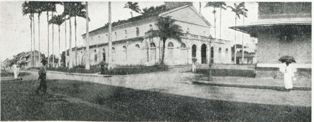
EGLISE ET PLACE DE L'ÉGLISE
