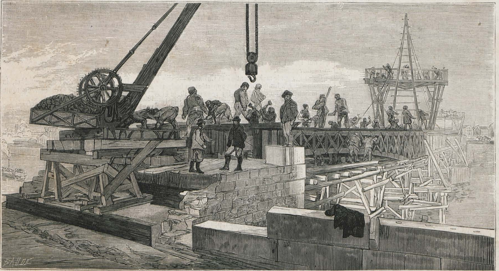
ÉTAT ACTUEL DES TRAVAUX DE CONSTRUCTION DE LA PASSERELLE DE PASSY.
