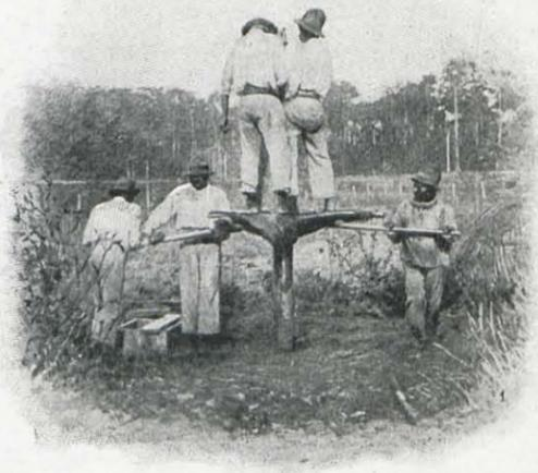
La prospection : le tube, enfoncé jusqu'au bed-rock, donne des échantillons de la terre aurifère avec lesquels on déterminera la richesse moyenne du placer.
