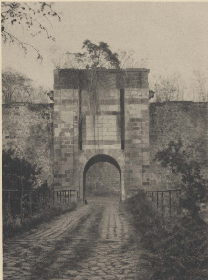
24. — Basse-Terre. — Entrée du fort Richepanse.
