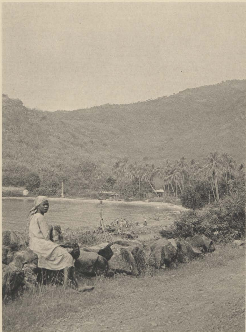
87. — Côte-sous-le-Vent. L'Anse à la Barque.
