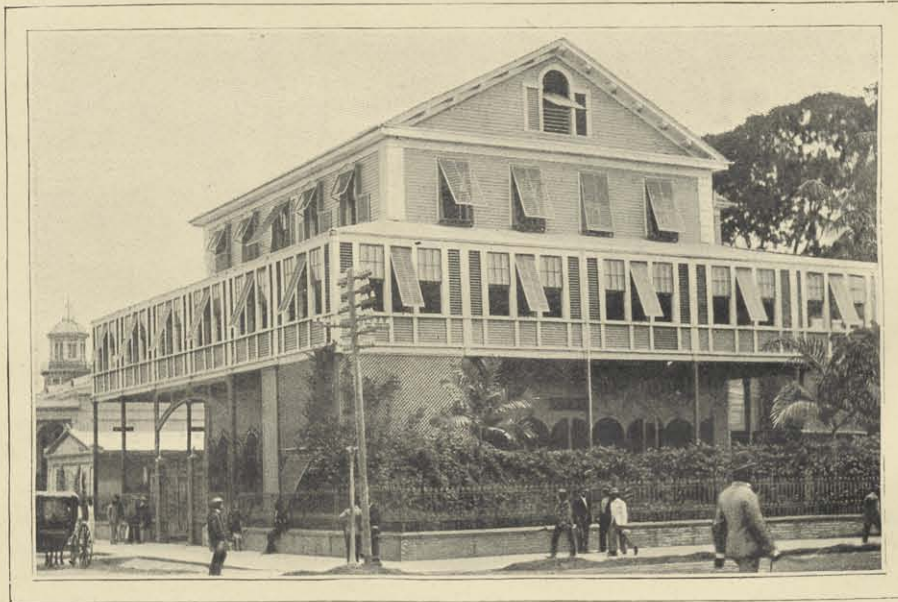
GEORGETOWN. PAVILLON DE LA BANQUE COLONIALE.
