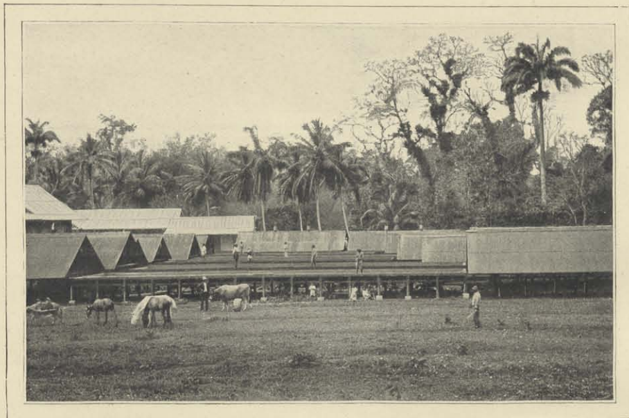
LE SÉCHAGE DES GRAINS DU CACAoyer SE FAIT SUR DES AIRES EN BOIS RECOUVERTES D'UN TOIT MOBILE (page 572).
