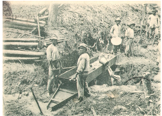
Figure 7 Crible métallique en sortie d'un sluice (ancienne carte postale, Suriname)
