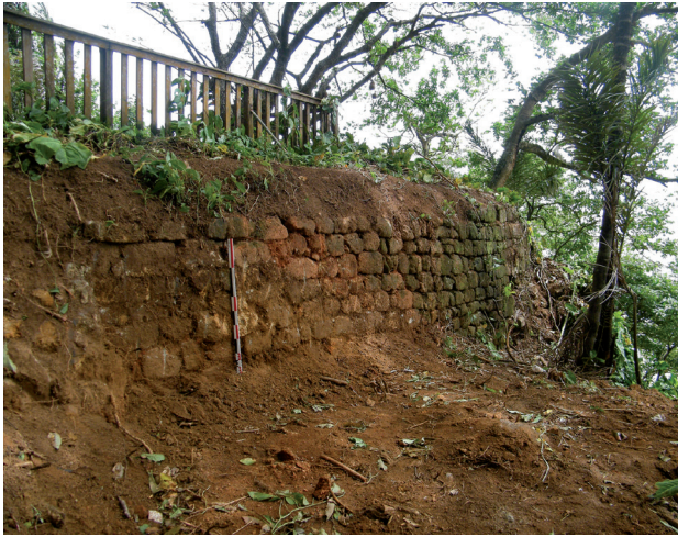
Figure 3 Vue du mur de terrasse au sud-ouest
