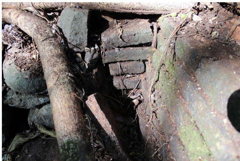
Figure 5 Mur de briques enchâssé dans le glacis
