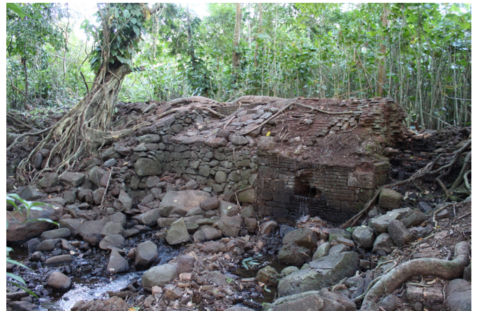
Figure 3 Le barrage poids, cliché N. Cazelles 2014
