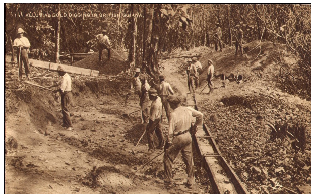
Figure 18 Chantier linéaire (ancienne carte postale, Guyana)
