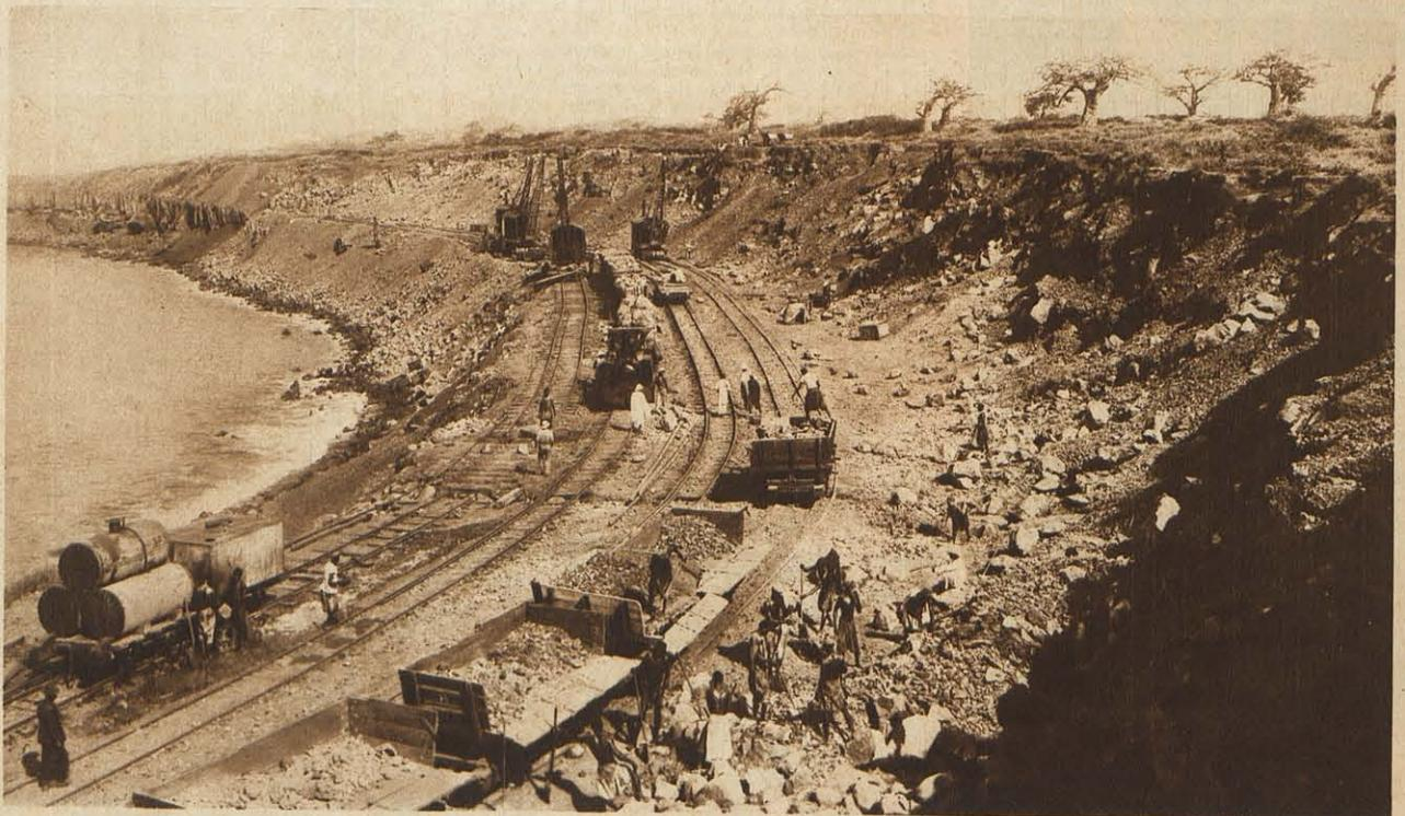
Carrière d'Ouakam où, grâce à l'air comprimé, 400 ouvriers relèvent 1.200 mètres cubes de matériaux par jour.
