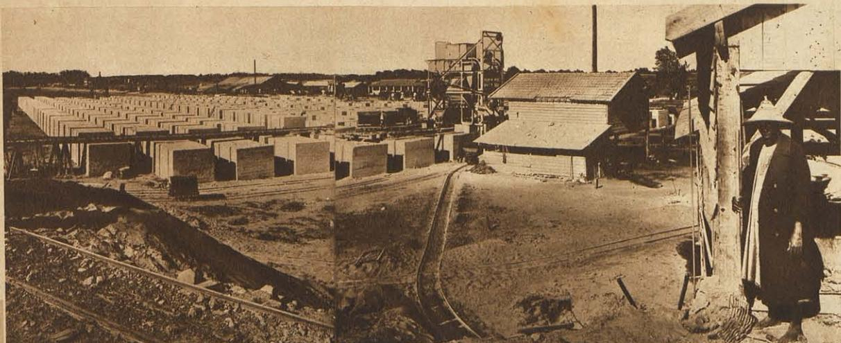
Chantier de fabrication des blocs artificiels destinés à l'aménagement du grand port moderne de Dakar. PHOTO TENNEGUIN
