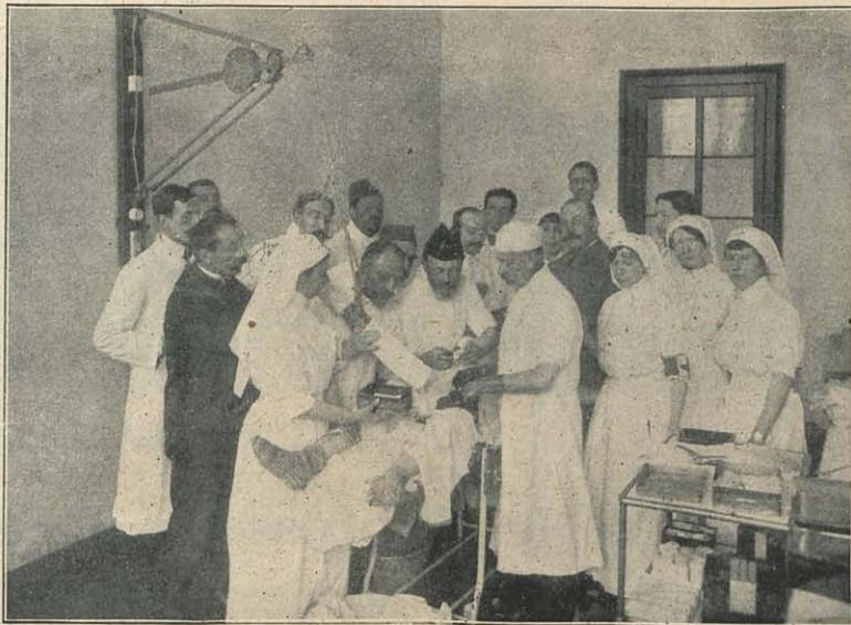
Le professeur Bergonié utilisant son électro-vibreur pour la recherche d'un projectile dans le corps d'un blessé. Guidé par l'appareil, le chirurgien peut intervenir à coup sûr pour enlever le projectile.
